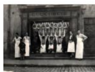
Gaston MEUNIER (1899) O filho dela à açougueiro
